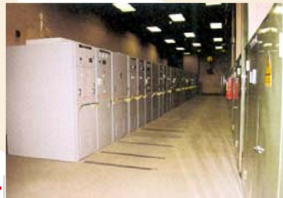
Renovación/ampliación S.C. Verdaguer. Vista parcial.
