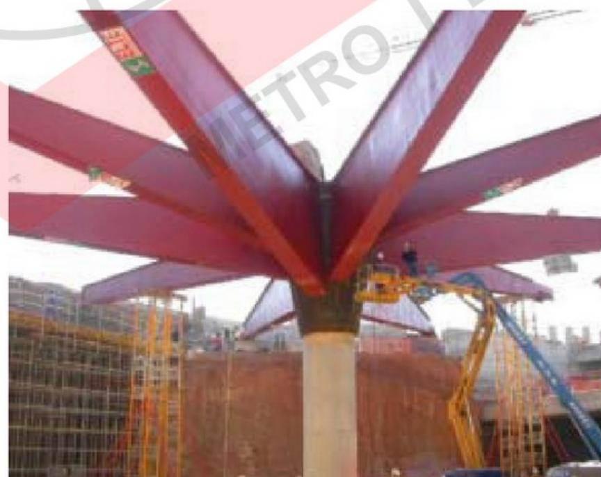
Foto 6. Estructura suport de la rotonda de la llosa d'entrada a la cotxera d'Horta.
