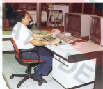
Con el telemando de energia mandamos y controlamos todos los equipos existentes en una subcentral.
